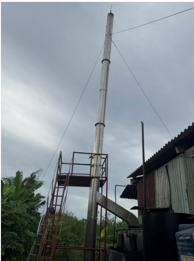
Hình 11. Hệ thống xử lý khí thải lò hơi tại nhà máy
